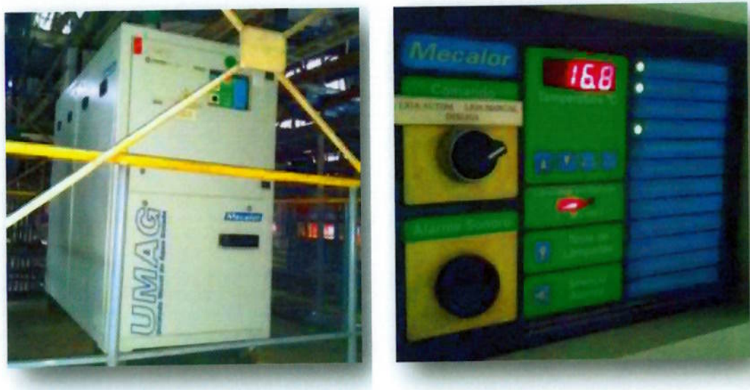
Figura 3.37 - Sistema de circuito fechado de refrigeração de água de resfriamento UMAG MECALOR (autoria própria).
